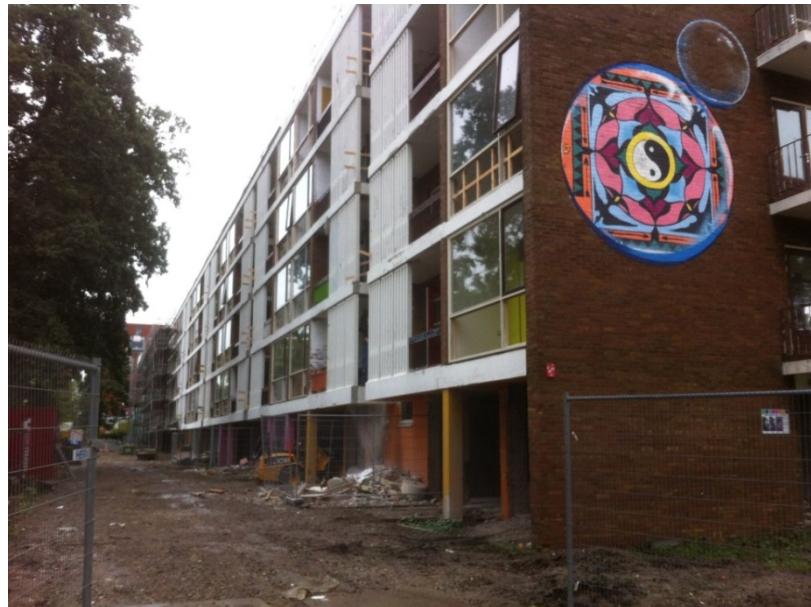
Figuur 2.4: Sloopwerkzaamheden van flat aan de Rooseveltlaan
