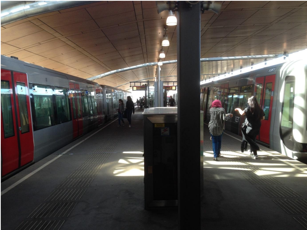
Figuur 7.2: Metrostation Schiedam Centrum
