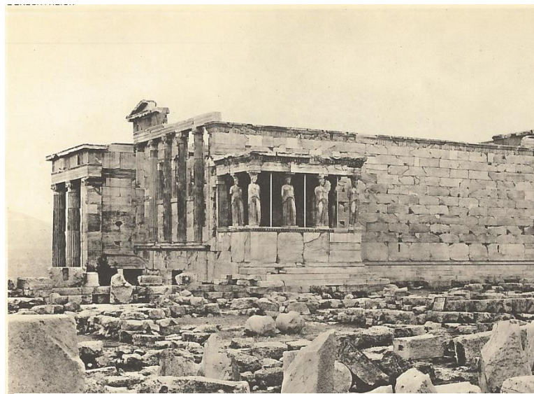
Figuur 4: Zuidkant van het Erechtheion dat de funderingen van de Archaïos Neos raakt.
