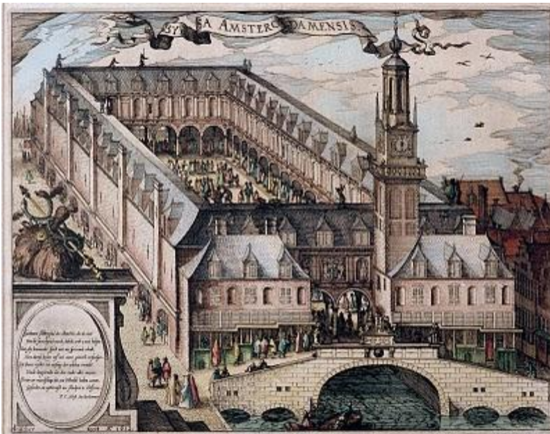
Afb.2. De Beurs van Hendrick de Keyser, gebouwd tussen 1608 en 1611.
