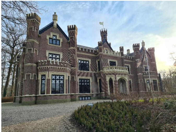
Afbeelding 1. Voorgevel Huis Schaffelaar te Barneveld.
