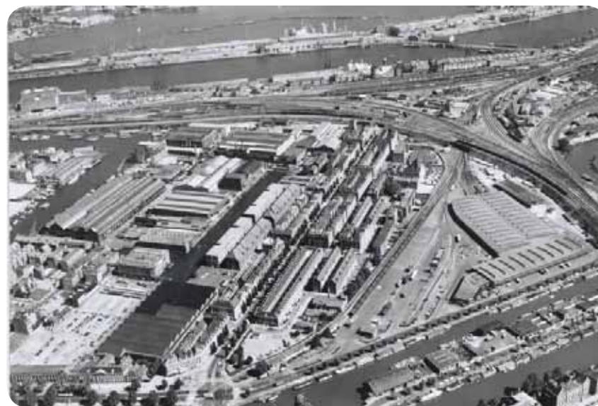
Afb.10 Voormalige Rookhuis VOC op Oostenburg te Amsterdam.
