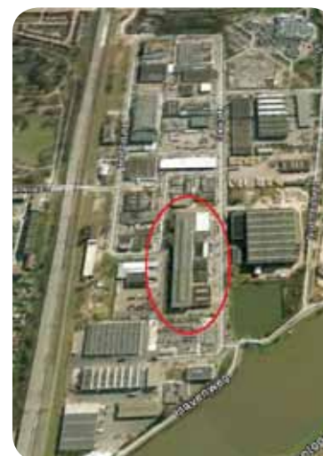
Afb. 79 Ligging machinale ijzerbewerking in 1964, definitieve opstelling terrein. Op deze foto is de oude machinale ijzerbewerking nog zichtbaar. De situering komt echter overeen.
