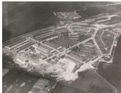
Foto 3.1: Spoorwijk in aanbouw, 1928.
