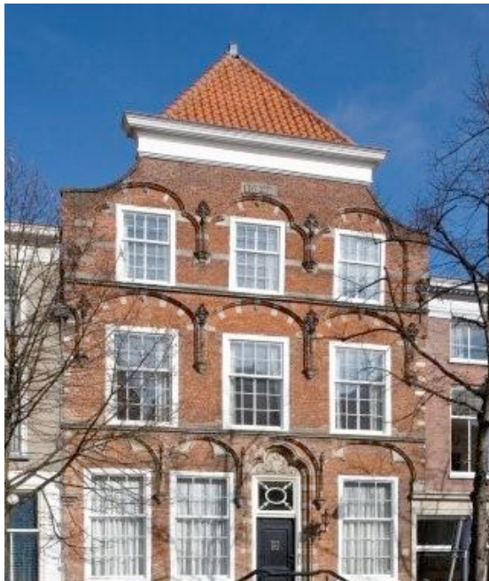
Afb. 12. Koornmarkt 64 met overkravingsbogen, het onderste gedeelte van de gevel is gedateerd 1545, Delft.
