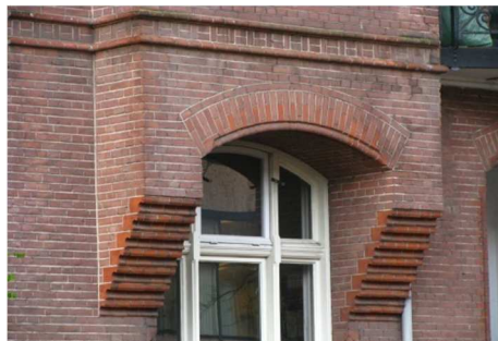
Afb. C.71 Detail van de karakteristieke zware erkerondersteuning met trapsgewijs uitkragende consoles
