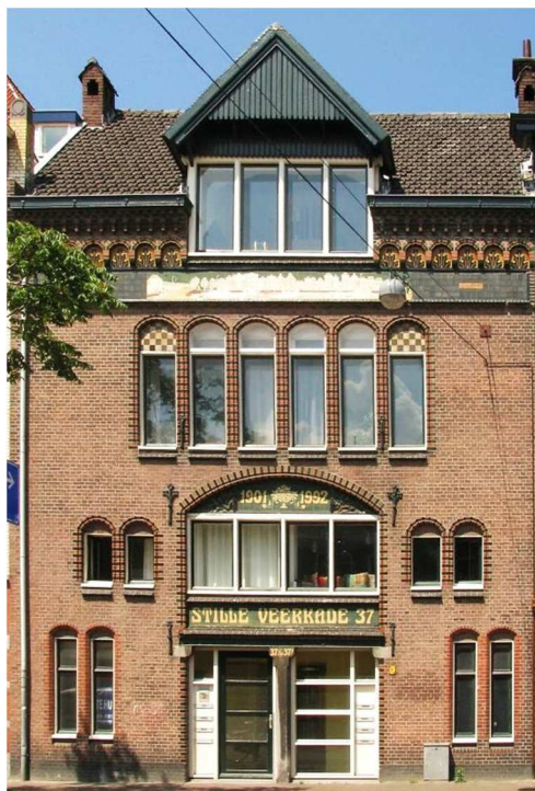
Afb. C.60 Het voormalige gebouw van de R.K. Volksbond aan de Haagse Stille Veerkade
