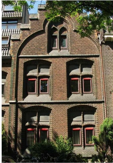
Afb. C.11 De gevel van het voormalige redemptoristenklooster
