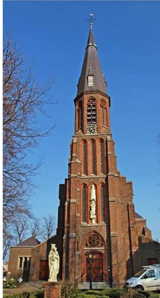
Afb. C.17 De westgevel van de Sint-Rochuskerk in Rijkevoort
