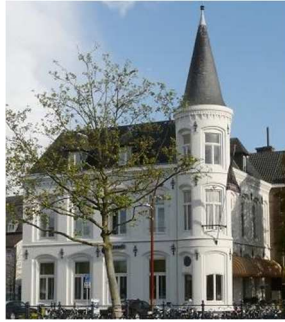
Afb. 4.8 Voormalig postkantoor in Breda (1880-1881)
