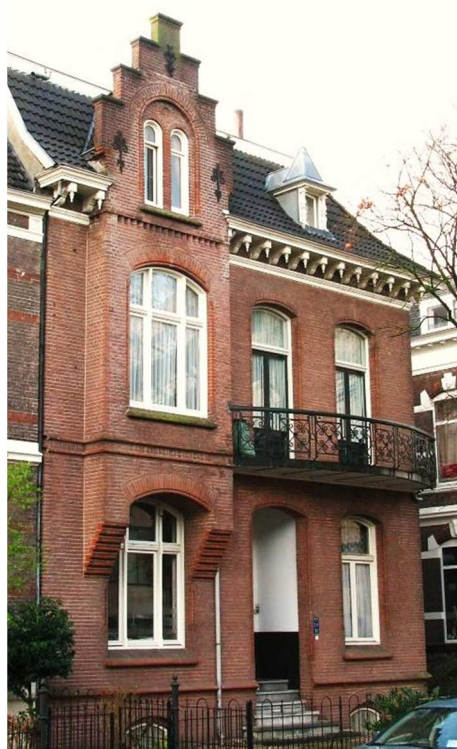
Afb. C.70 De voorgevel van het huis van Dickmann met uitkragende erker, bekroond door een trapgevel
