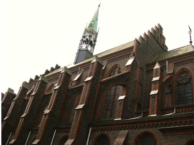
Afb. C.31 (l) Zicht op het schip en een deel van het koor, geschoord door luchtbogen
