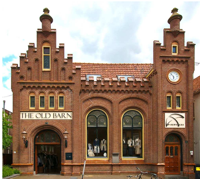
Afb. C.93 Voormalige Spaarbank, Barneveld
