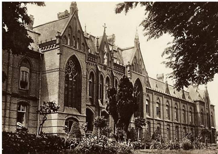
Afb. C.82 Een groot deel van de voorgevel van het rustoord annex gesticht
