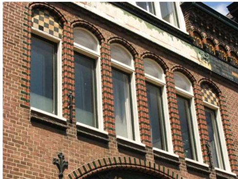
Afb. C.61 Serie van zes geprofileerde segmentboogvormige vensters op de tweede verdieping van het gebouw
