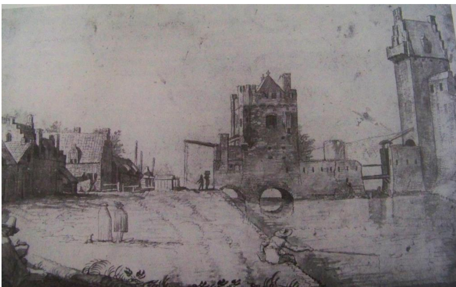
Zichtbare scheuren in het muurwerk van de middeleeuwse voorganger van de Wittevrouwenpoort, anonieme tekening ca. 1600.
