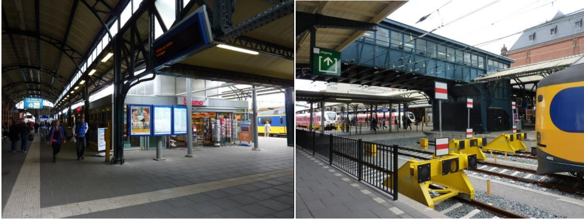
Figuur 4.3: Beperkte zichtlijnen door commerciële unit en oude passerelle
