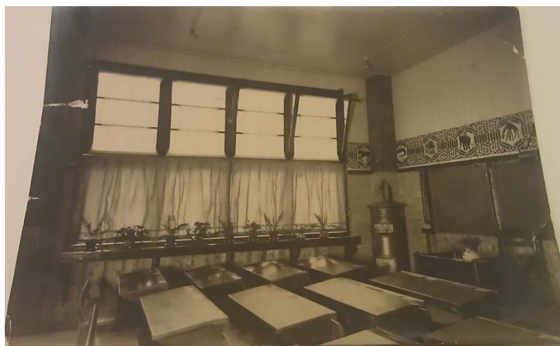
Afb. 7. Interieur van een Utrechtse school, 1923-1924. Hier is een kachel die Ros bespreekt zichtbaar.
