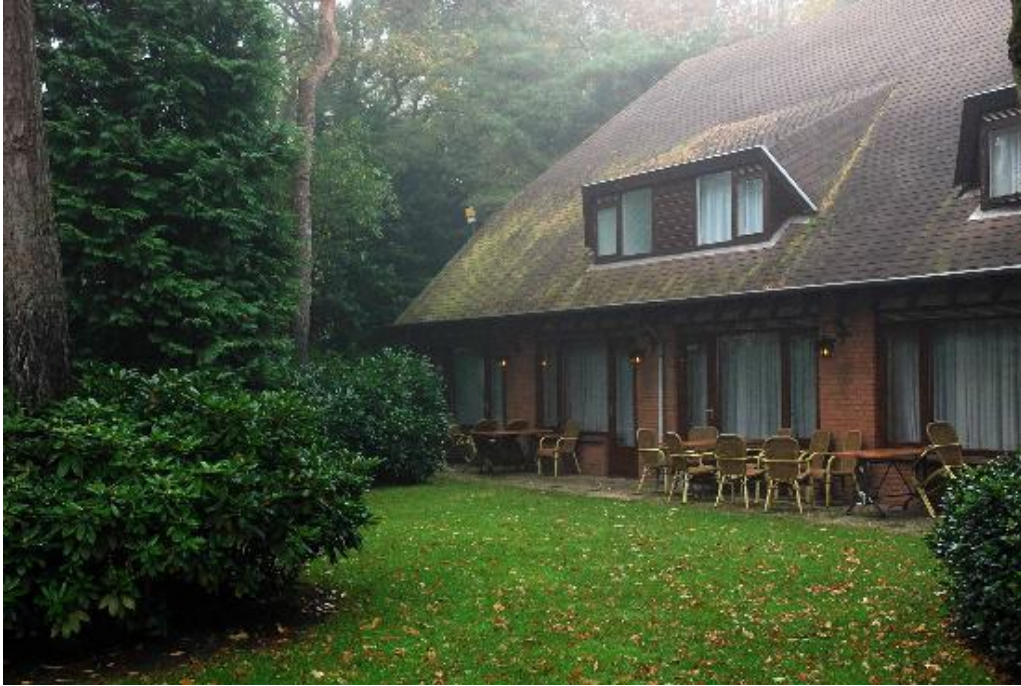
Figuur 75: Achterzijde van de motelkamers, huidige situatie
