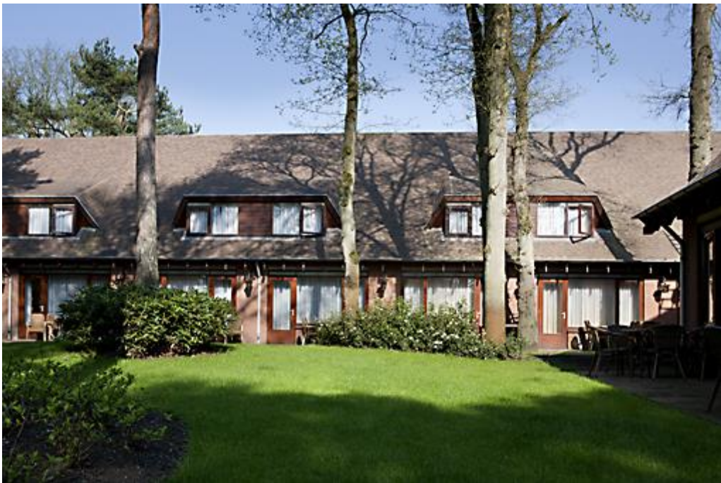
Figuur 76: Achterzijde van de motelkamers, huidige situatie
