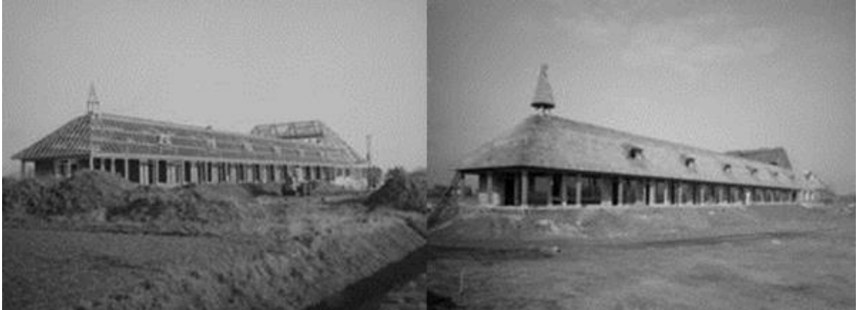
Figuur 57: Motel Nuland in aanbouw inclusief het karakteristieke torentje, 1968
