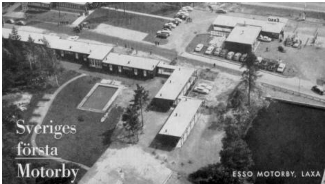
Figuur 19: Luchtfoto Esso Motor Hotel Laxa
