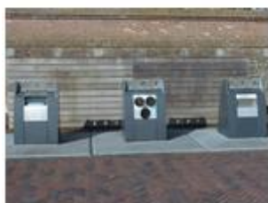
afvalcontainers havenkantoor → AN
