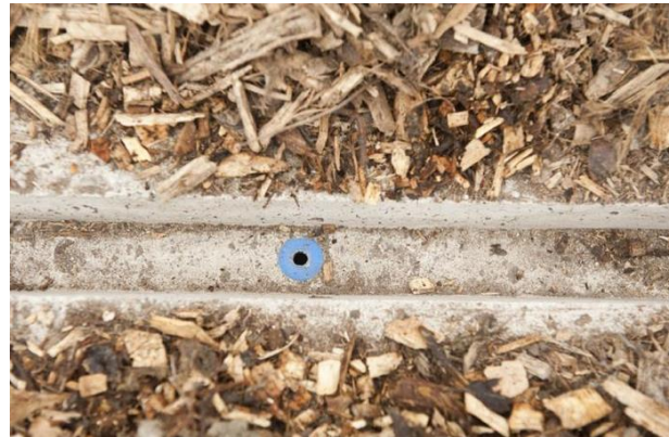
Een spigot in de betonnen vloer waardoor de lucht de bedding in geblazen wordt.
