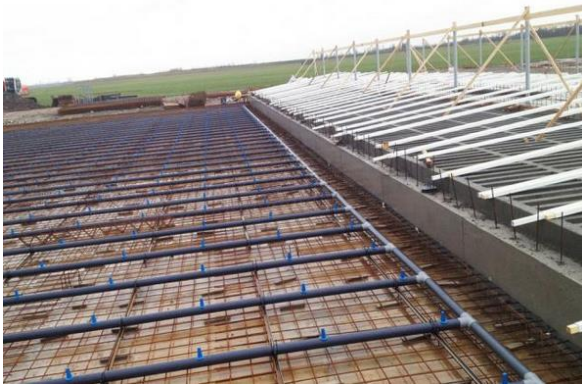
Buizenstelsel van het beluchtingssysteem voordat de bovenste laag beton gegoten werd.
