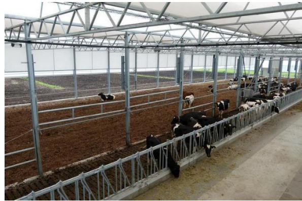
Grote bedding met de verticaal schuivende hekken waarbij tevens de zeilen als zijwanden zichtbaar zijn.
