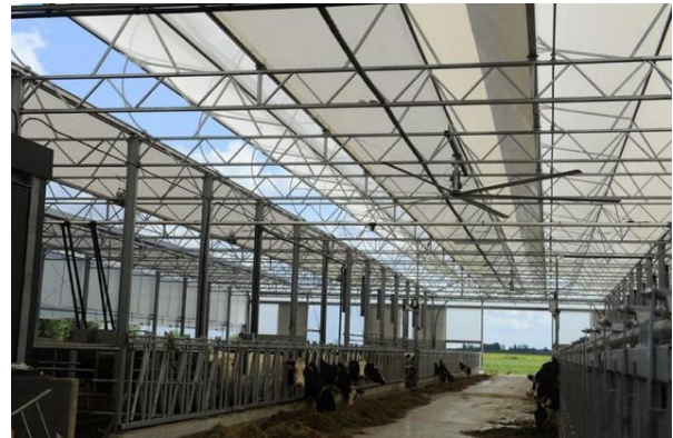
Dak met melkwitte platen en luchtinlaten.
