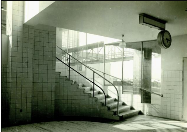
Centrale hal met trapopgang naar directiekantoor.
