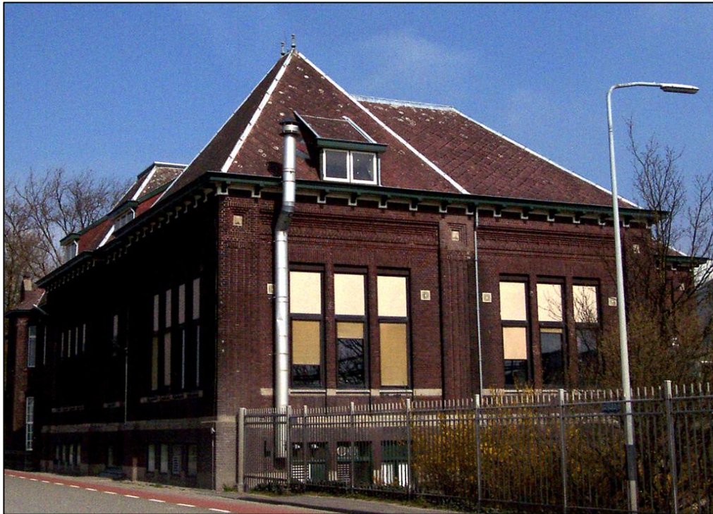
Noordzeedijk 113 Dinteloord (Stampersgat).
