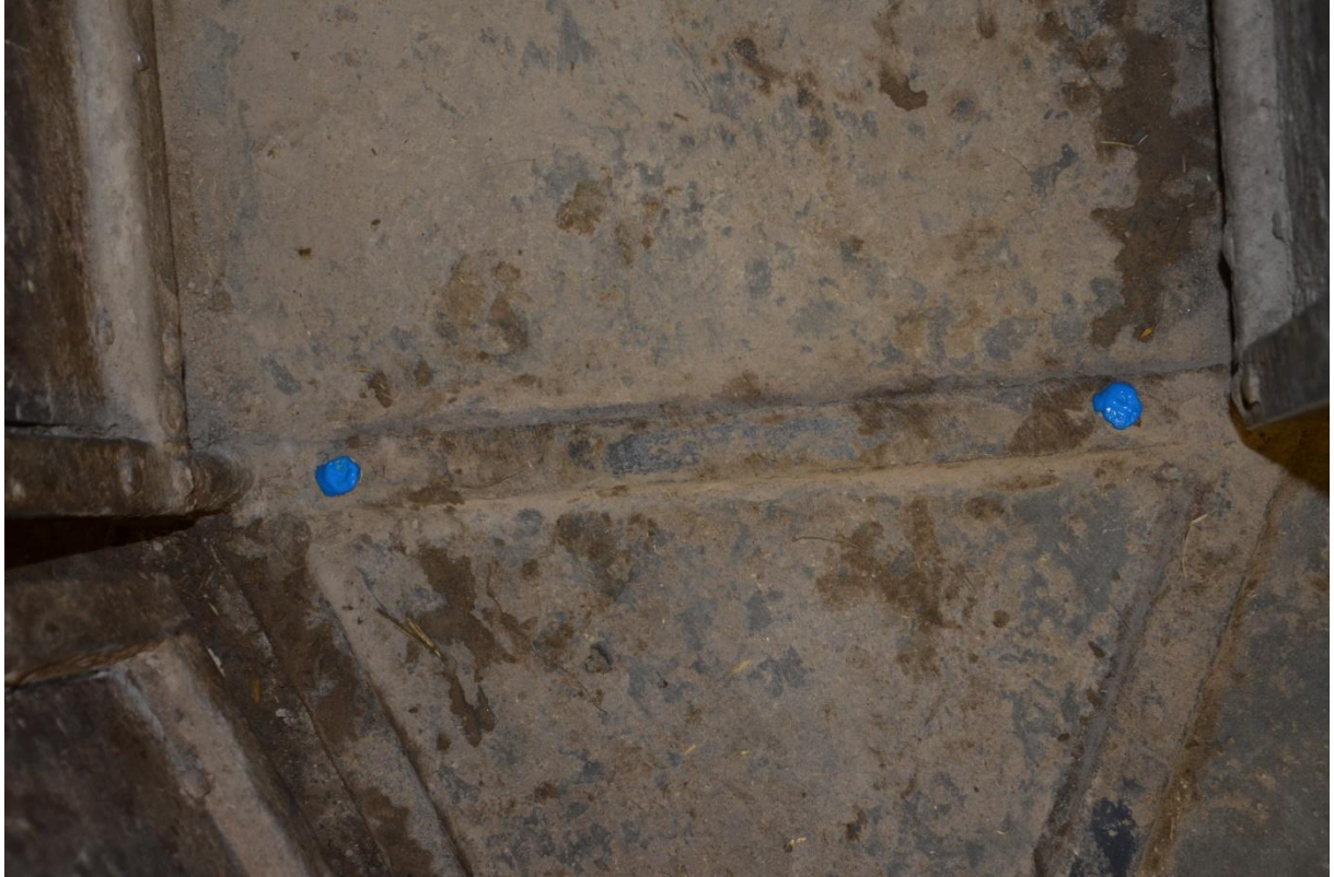
De bouten in de uitgang van het voerstation
