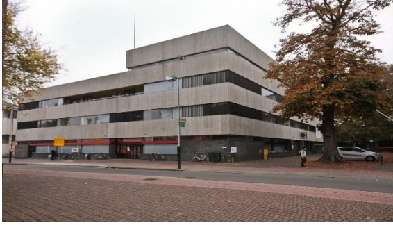
De voorkant van het gebouw in Hilversum
