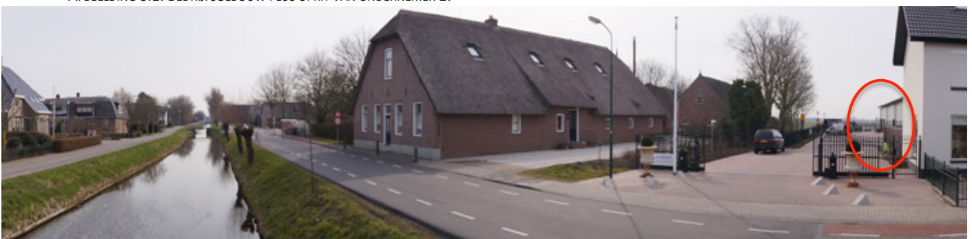
AFBEELDING 6.1: BEDRIJFSGEBOUW PLUS OPRIT VAN ONDERNEMER 1.
