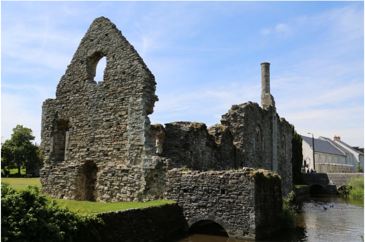
Vroegst bekende pijp voor de afvoer van rook, Constable's House, Christchurch Castle, Christchurch, ca. 1160.
