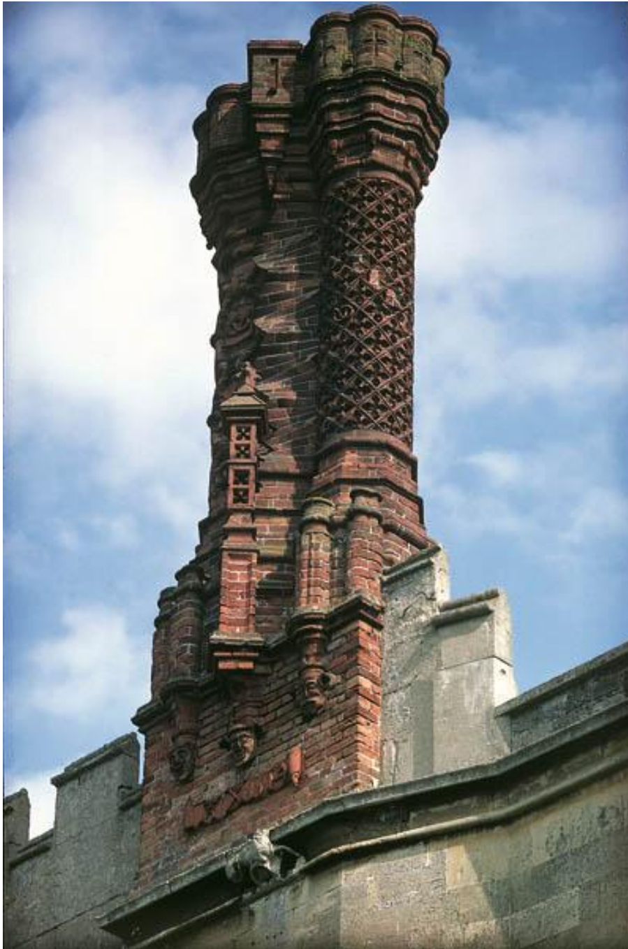
Gegroepeerde, rijk gedecoreerde bakstenen schoorstenen, Thornbury Castle, Gloucestershire, 1514.
