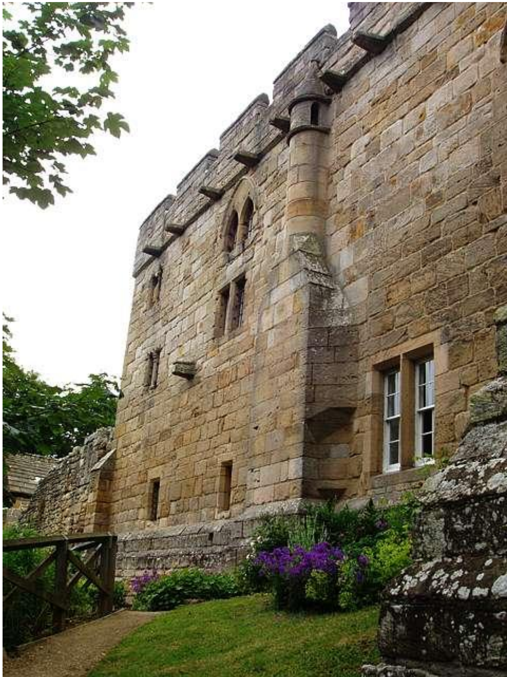
Rookkanaal tegen de buitenmuur, Aydon Castle, Northumberland, ca. 1280.
