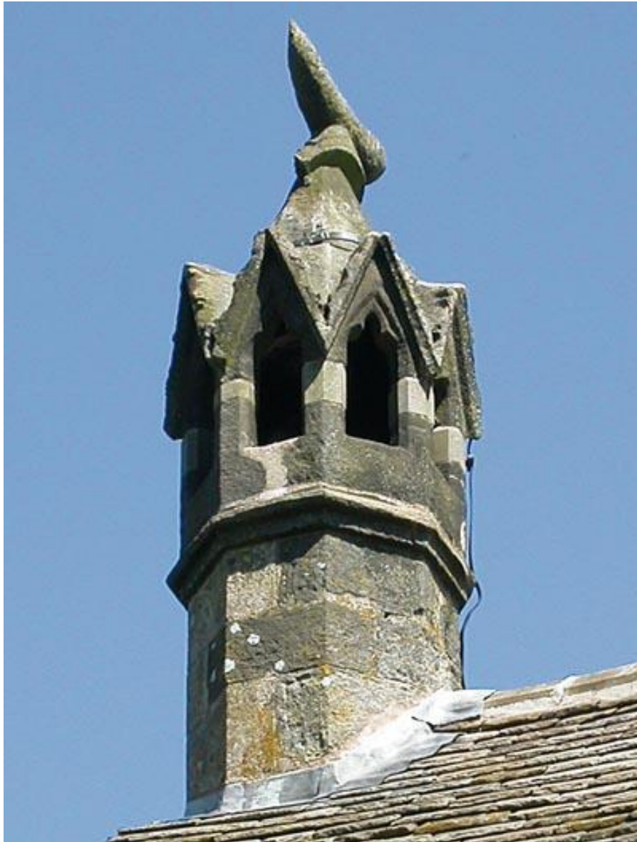
Schoorsteen met sleuven aan de zijkant voor de rook en een kegelvormige top, St. Briavels, Gloucestershire, laat 13 e eeuw.
