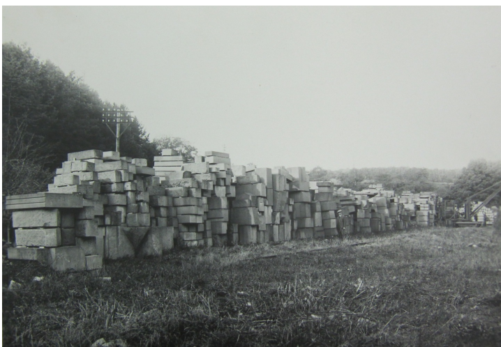
Afbeelding 18 De funderingswerkzaamheden van het museum zijn gedocumenteerd door vele foto's.
