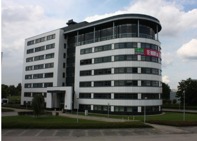
Figuur 4.1.4: Kantoorruimte te huur in Rijnhuizen
