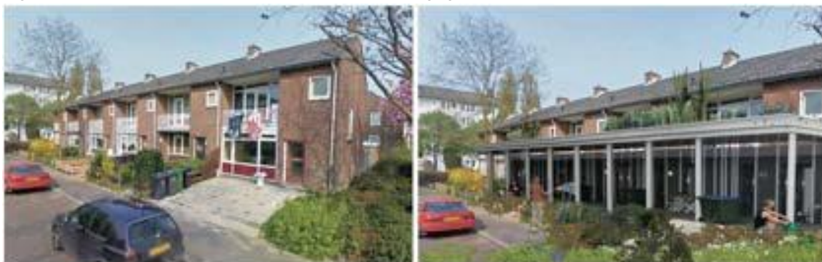
Figuur 5.6: Waterveranda ten behoeve van hemelwaterberging.
