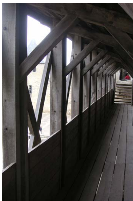
Door Eugène Viollet-Le-Duc nagebouwde houten weergangen (hordijs) op de muur en rond de torens van het Château Comtal in de citadel van Carcassonne
