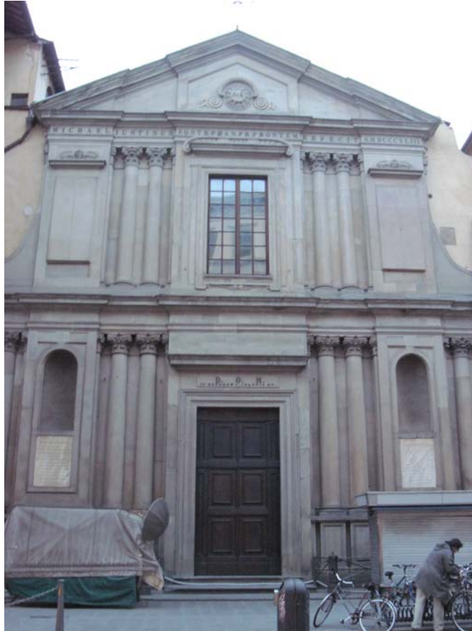
Fig. 10 Firenze, Via dei Martelli, La chiesa di San Giovannino degli Scolopi. Fotografia dell'autore.
