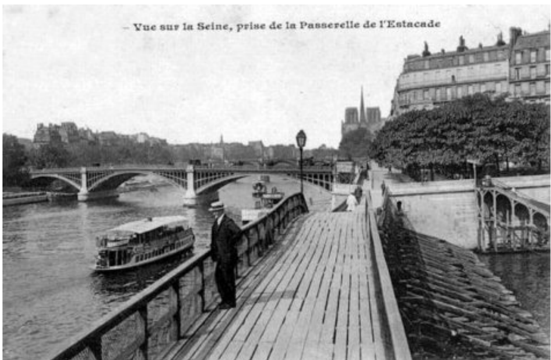
Image 2 : Vue sur la Seine, prise de la Passerelle de l'Estacade, ca. 1900. Paris
