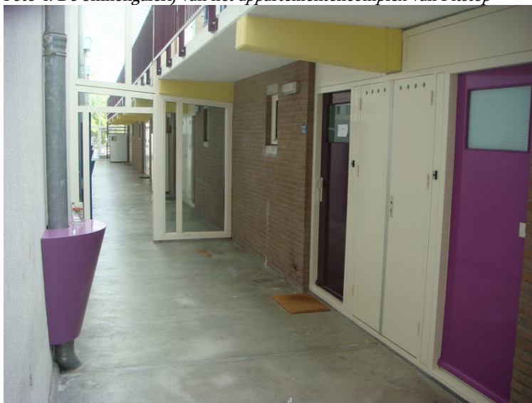
Foto 4: De binnengalerij van het appartementencomplex van Pitstop
