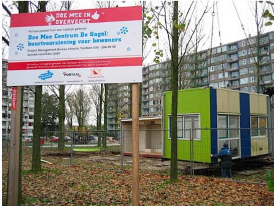
Foto 5: plaatsing van het Doe Mee Centrum
