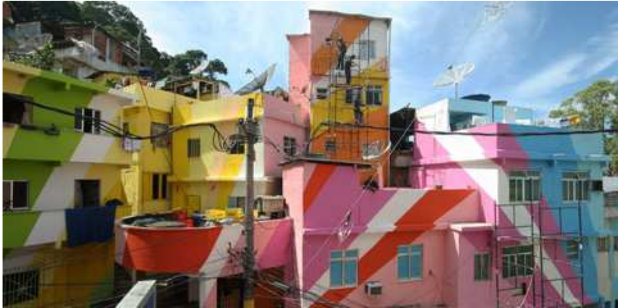
Het laatste afgeronde project van Haas en Hahn in Vila Cruzeiro, waarbij 36 woningen beschilderd werden.
