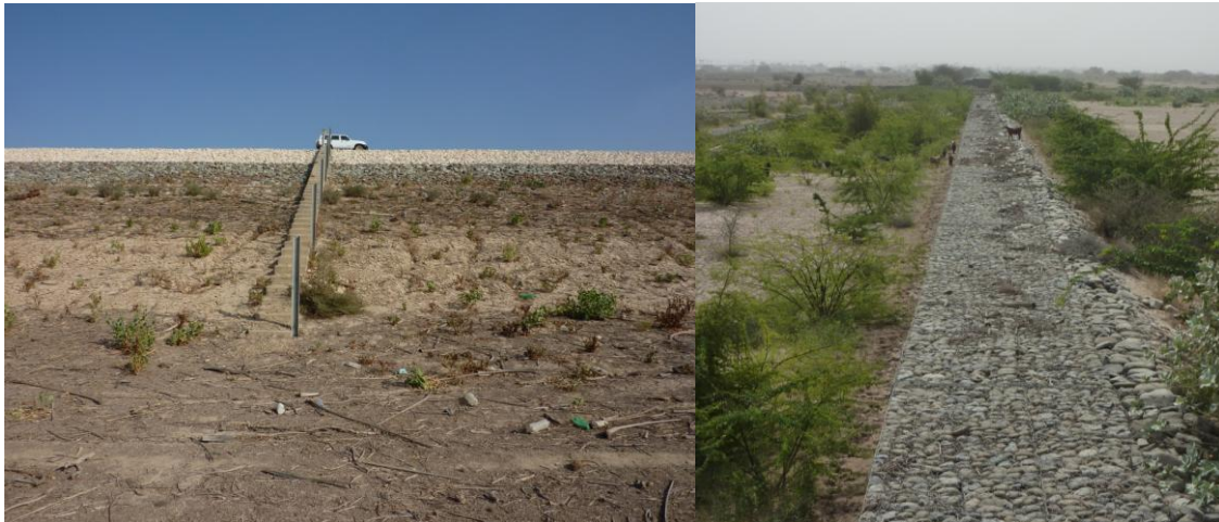
Fig. 3.1.6; Wadi Al Jizi Dam (left), Wadi Hilti dam (right)
